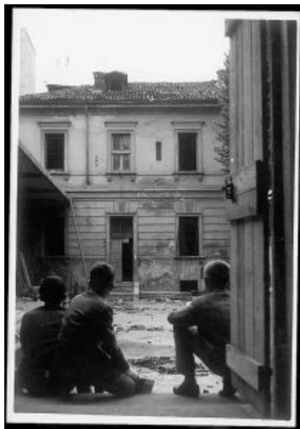
Foto della "Palazzina" nel periodo della sua demolizione (1962-63)
